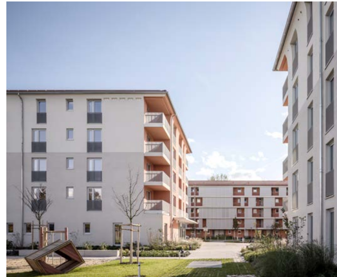
Auch der Münchner Norden wurde ausgezeichnet. In der Kämpferstraße sind 198 Wohnungen, ein neuer Quartiersplatz und eine Mobilitätsstation entstanden.
