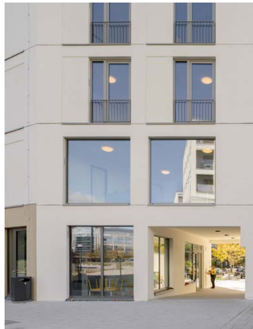
Die neuen Bewohner beleben die Nachbarschaft im Neuperlacher Zentrum. Mit dem Gebäude wird eine weitere Baulücke geschlossen.
