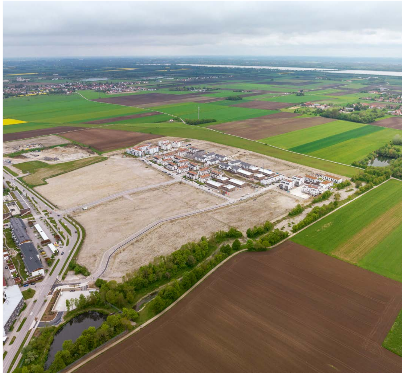
Erste Wohnhäuser sind am Lerchenwinkel bereits entstanden, wie die Aufnahme von Mitte 2023 zeigt. Die weiteren Baufelder werden in den kommenden Jahren entwickelt.
